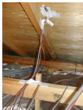
天井吊り木上 野地表面
