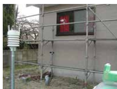
気象ステーション(温湿度・風向風速計など) と日射計【実験棟北側】
