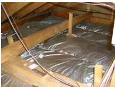
天井断熱施工状況
