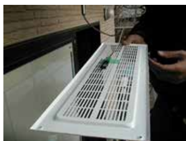
軒天換気口 風速計
