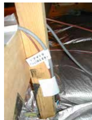
天井吊り木 直上
