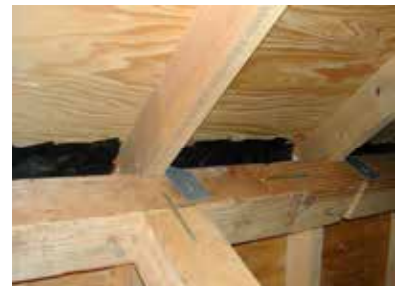
軒換気口は軒一軒換気の場合 気密テープで塞ぐ
