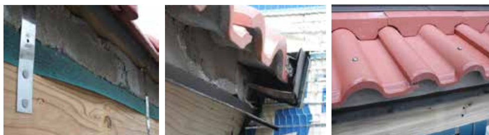
野地ルーフィングと軒先瓦の間(雀口)に無収縮モルタルを充填し水上面戸部品も裏籠め固定する。
