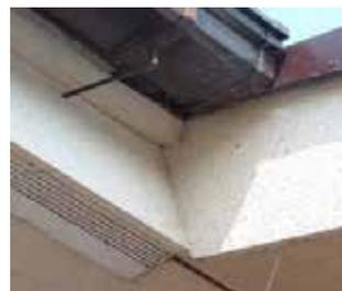
軒先瓦の裏面と広小舞板(ルーフィング仕舞)の間に空隙。軒天換気材と軒先板金の裏に隙間が。
