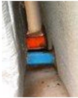
奥の給湯機が外壁に接近しすぎ。機器カバーが隙間を塞ぎ給湯保温管の蟻道痕を見逃がす。
