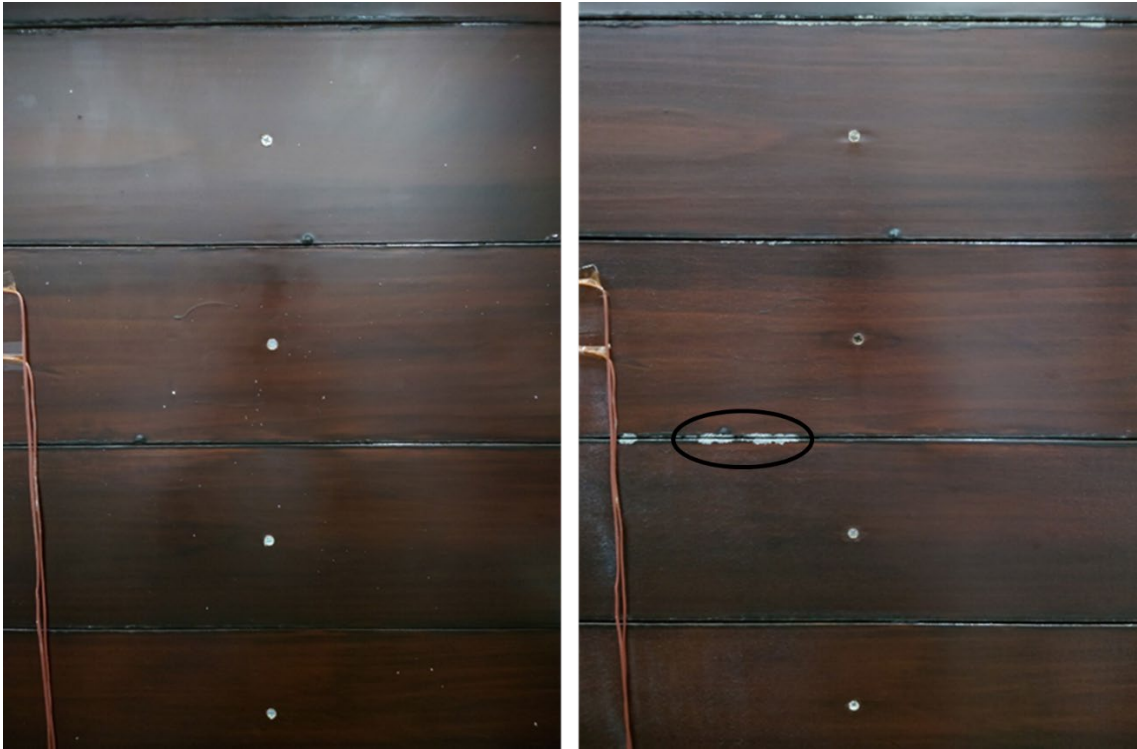
写真7 試験体 B の促進劣化前（左）と促進劣化後（右）の外観
