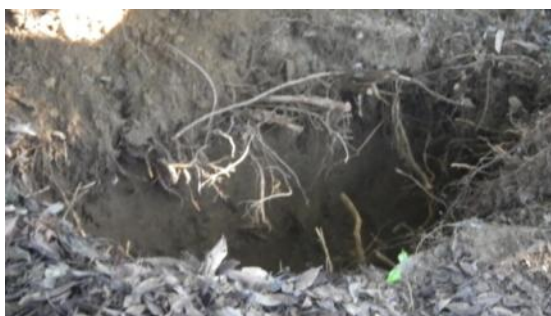
写真 6 a 細かい根は剪定ばさみで切断・除去
