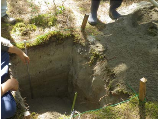
写真 10 穴掘りならびにパイプ設置状況
