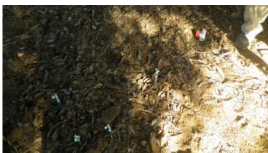
写真 8 埋め戻し後の状況
