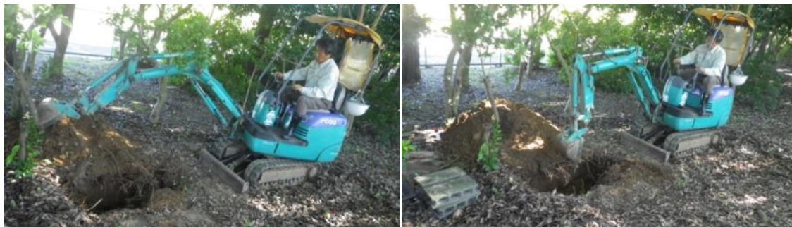
写真5 小型ユンボによる掘削作業
