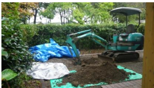
写真 1 3 ユンボでの掘削状況
