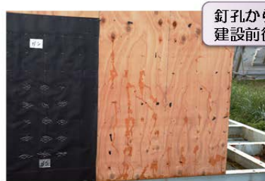
アスファルトフェルト8kg/巻品、風速5m/s、4分間撒水後 (防水紙を剥がした状態)
