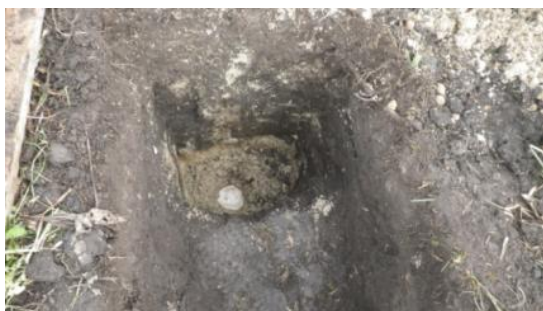
写真1 掘削中の穴（湧水）
