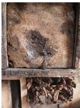
写真 4a, b 褐色腐朽（柱脚部）
