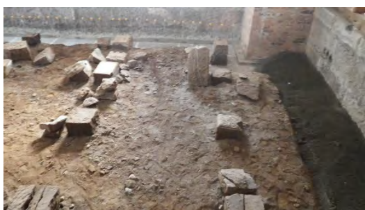
写真 2 束石（札幌軟石） 水分の滞留・乾燥こともない害れが認められる。
