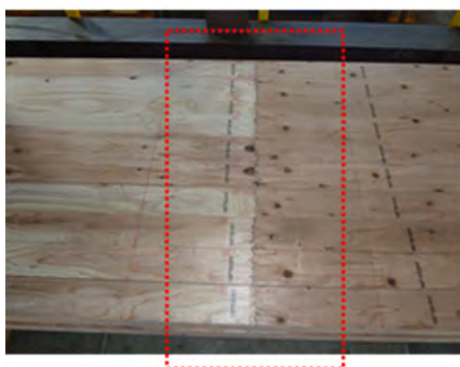
最外層スカーフジョイント確認
