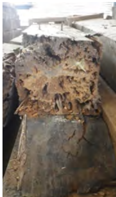
写真 4a, b 褐色腐朽（柱脚部）
