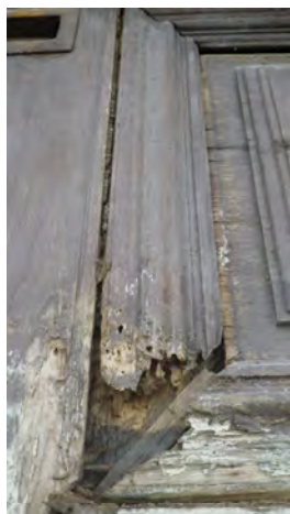
写真 6 筋交脚部の穿孔被害
