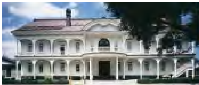
写真 1 調査対象外観（改修工事状況 HP より）
