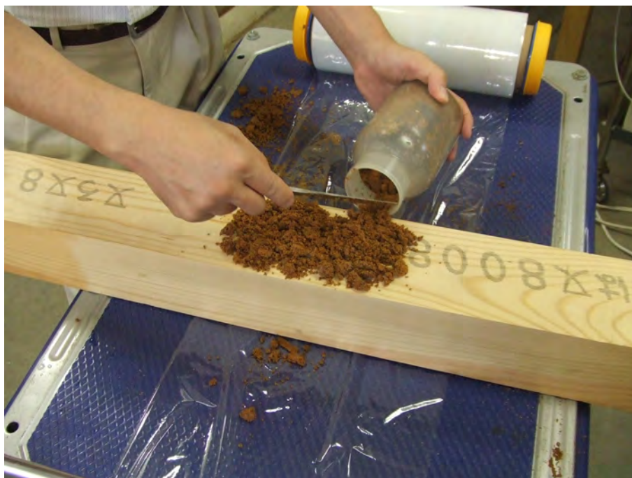
写真 5.2.3 ナミダタケを培養した木粉培地を土台部材に直接盛り付けた様子
