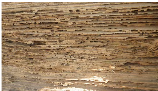
写真 9a, b 土台部分の被害（原因特定できず）
