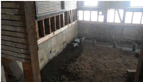
写真 10 補修時に取り替えた土台
