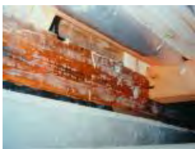
写真10 気密が悪い結果、間仕切り壁下部土台に発生したカビ被害
