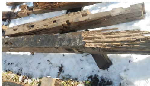
写真 9a, b 土台部分の被害（原因特定できず）
