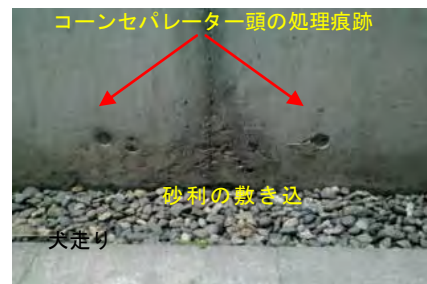
犬走り剥離事例と浸水防止にシーリングを施した事例 基礎と隔離した溝に砂利敷き込みをした事例
