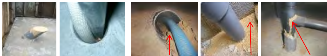
更新の容易な設備配管用の鞘管埋設状況
