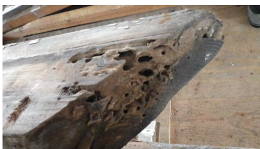
写真 6 筋交脚部の穿孔被害
