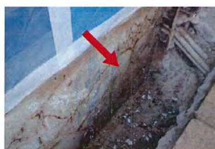
基礎部分拡大
