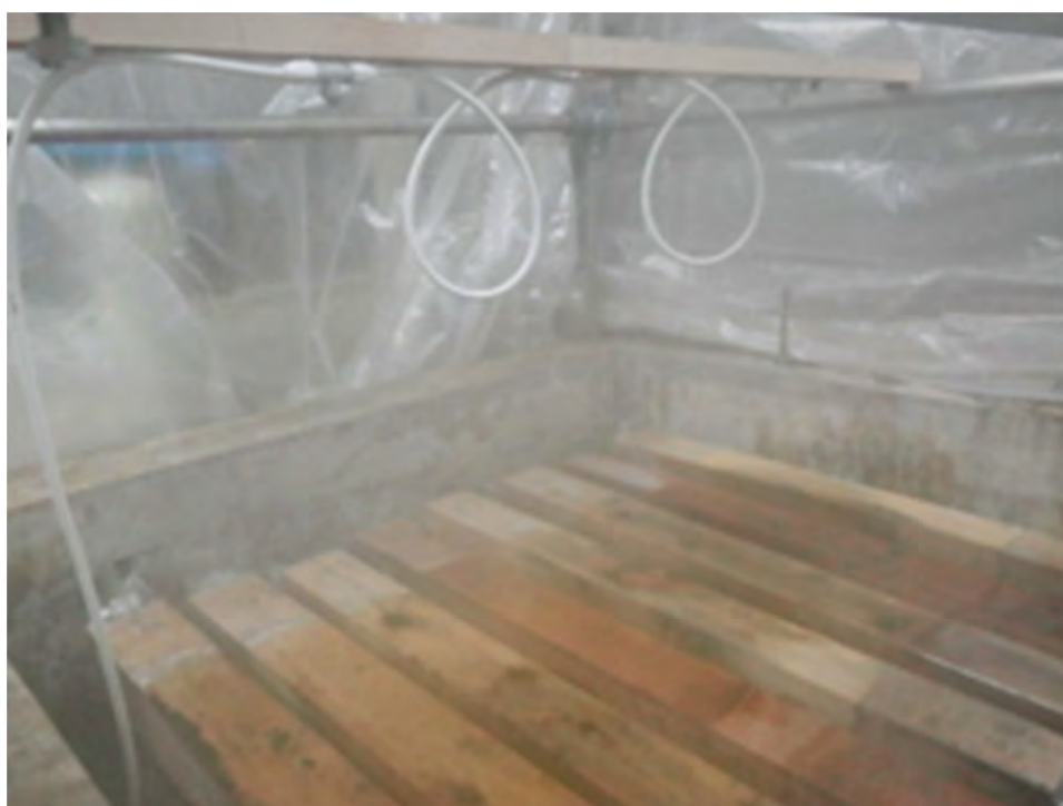
写真 5.2.7 ミストシャワーによる散水状況
